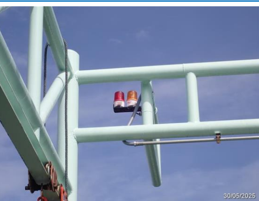
รูปที่ 3-20 ไฟสัญญาณแสดงตำแหน่งท่าเทียบเรือ
